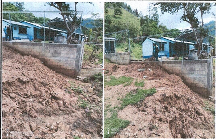
Foto 3: Mejoramiento de muro perimetral.
