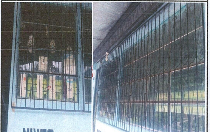
Foto 4: Mejoramiento de barandas.
