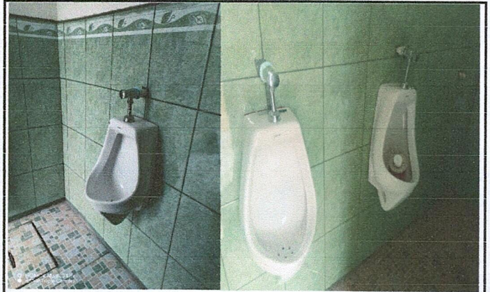
Foto 2: Mejoramiento de servicios sanitarios y sus accesorios.
